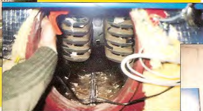
Interno del boiler dopo 5 mesi di trattamento: i sali di calcio si depositano sul fondo.
