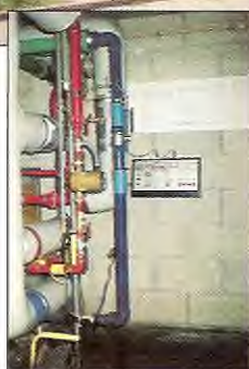
Installazione di un D-CALC P-52 nell'entrata d'acqua fredda e di un D-CALC PLUS nel riciclo d'acqua calda.
