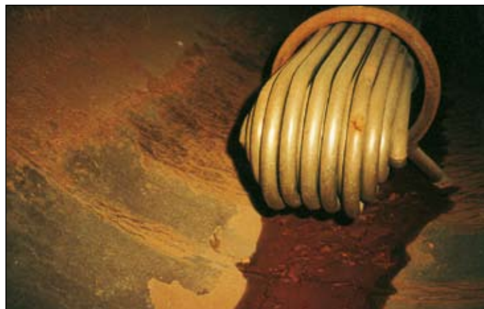
Après 2 mois de traitement et nettoyage à haute-pression
