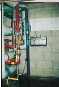
Installation d'un D-CALC P52 sur l'arrivée d'eau froide et d'un D-CALC Plus sur le retour d'eau chaude.
